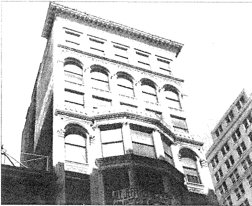
Terra cotta façade
